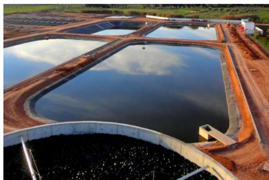
Station d'épuration de la ville de KELAA
