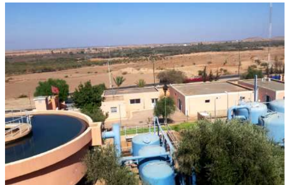
Type : Conventionnel avec filtration à sable Débit traité : 70 l/s Eau brute : Prise sur canal
