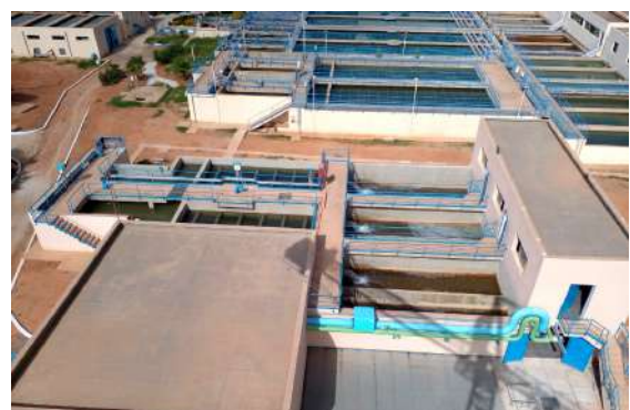
Type : Conventionnel avec filtration à sable Débit traité : 130 l/s Eau brute : Prise sur barrage et canal
