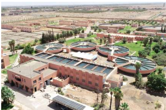
Type : Conventionnel avec filtration à sable Débit traité : 1400 l/s Eau brute : Prise sur canal
