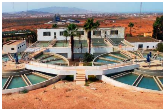
Type : Conventionnel avec filtration à sable Débit traité : 840 l/s Eau brute : Prise sur canal Bouareg
