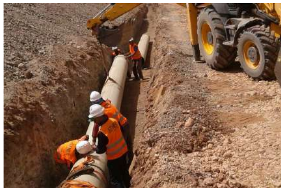
Diamètre : 700 mm Longueur : 20 Km Matériaux : PRV / AGC
