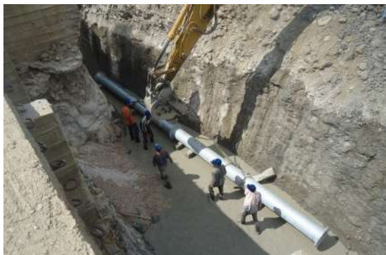
Diamètre : 450 mm Longueur : 60 Km Matériaux : AGC / FD / PVC
