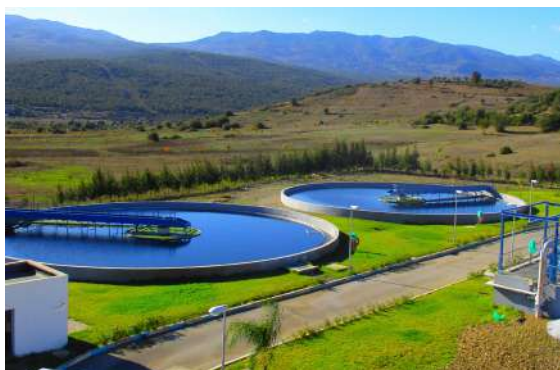
Station d'épuration de la ville de CHEFCHAOUEN
