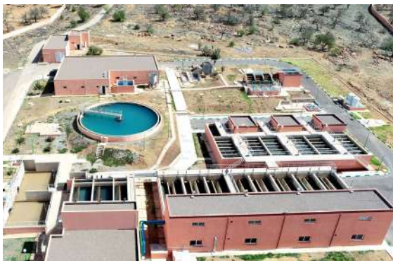
Type : Conventionnel avec filtration à sable Débit traité : 300 l/s Eau brute : Prise sur barrage
