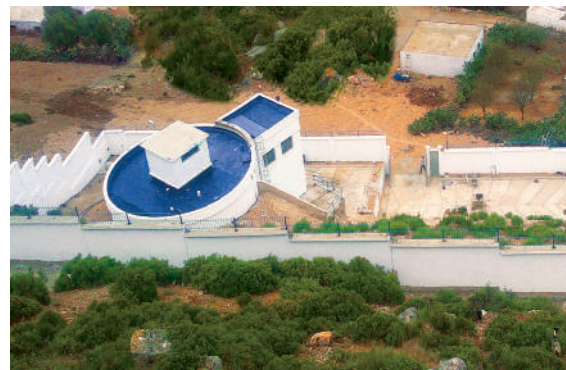
Type : Semi enterré Capacité : 1 500 m 3 - 500 m 3
