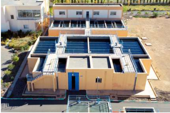
Type : Conventionnel avec filtration à sable Débit traité : 320 l/s Eau brute : Prise sur barrage
