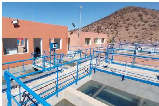
Type : Conventionnel avec filtration à sable Débit traité : 40 l/s Eau brute : Prise sur barrage
